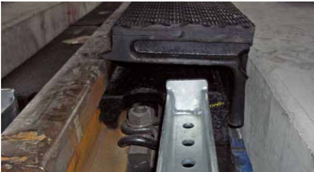
Posa degli elementi profiSTRAIL esterni (senza gola). Montaggio della prima battuta (dispositivo antiscorri-mento).
