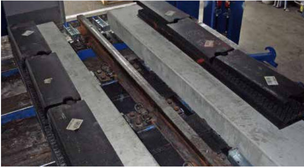
Preparazione delle connessioni e degli elementi profiSTRAIL interni ed esterni.
