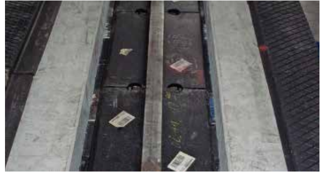
Montaggio delle connessioni e allineamento degli stessi alla suola della rotaia. All'occorrenza spalmarli con della pasta di montaggio* .
