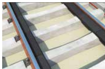
Einlegen der Schienenformstücke.
