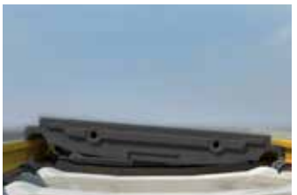
innoSTRAIL Innenplatte auf einer Seite unter den Schienenkopf einlegen und auf der anderen Seite die Spurrillenabstützung mit Montagepaste einstreichen.
