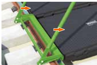
Den Plattenrand mit dem Einbauhebel zusammendrücken bis die Spurrillenabstützung unter den Schienenkopf rutscht.
