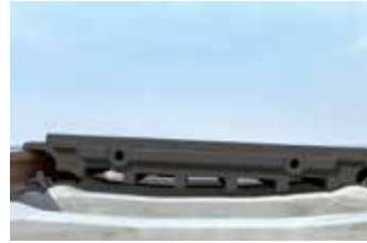
pedeSTRAIL Innenplatte auf einer Seite mit der Lippe unter den Schienenkopf einlegen und auf der anderen Seite die Lippe mit Montagepaste einstreichen.
