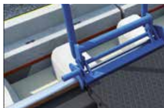
Den Einbauhebel öffnen und unter dem Schienenkopf einhaken.
