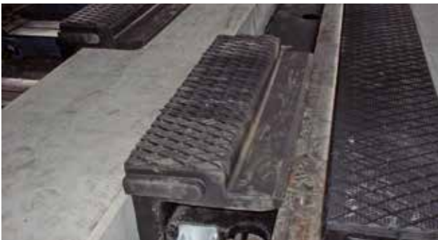
Pose des éléments profilSTRAIL intérieurs (avec ornière). Monter en premier le dispositif d'antiglisement.
