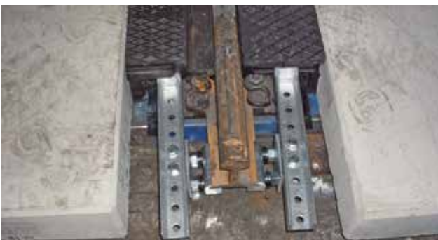
Bien encaster le dispositif d'antiglisement dans les profils avant de les visser. (Ne pas trop serrer le dispositif pour éviter la surpression).
