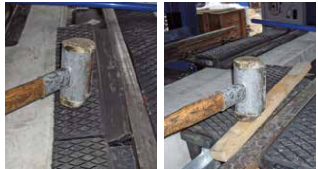
Faire rentrer et aligner les éléments profilSTRAIL en se servant du marteau. Le cas échéant, se servir d'une barre ou du levier de montage* .
