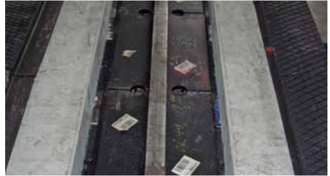
Poser et adapter les pièces compensatrices en direction du patin de rail. Recouvrir de pâte de montage* si besoin.
