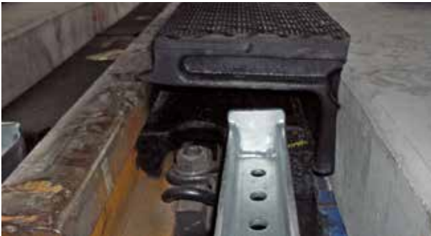
Pose des éléments profilSTRAIL extérieurs (Sans ornière). Monter en premier le dispositif d'antiglisement.
