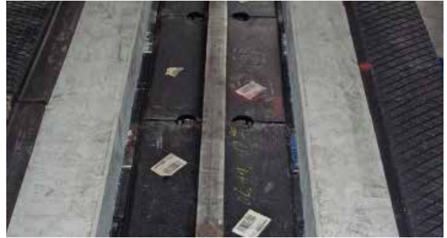
Einbauen und Einrichten der Schienenformstücke zum Schienenfuß hin.
