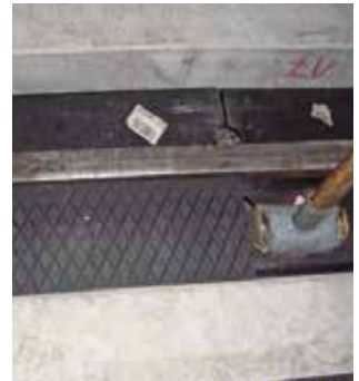
Einschlagen und Ausrichten der profilSTRAIL Elemente mit dem Kunststoffhammer.
