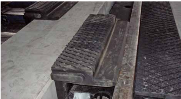
Aufsetzen der profilSTRAIL Elemente innen (mit Spurrille). Erste Verschiebesicherung als Anschlag montieren.
