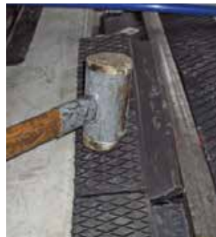
Einschlagen und Ausrichten der profilSTRAIL Elemente mit dem Kunststoffhammer. Bei Bedarf eine PE Leiste oder den Einbauhebel* zur Unterstützung verwenden.
