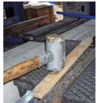
Einschlagen und Ausrichten der profilSTRAIL Elemente mit dem Kunststoffhammer. Bei Bedarf eine PE Leiste oder den Einbauhebel* zur Unterstützung verwenden.
