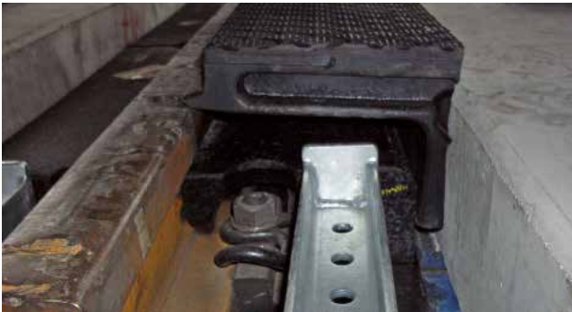
Aufsetzen der profilSTRAIL Elemente außen (ohne Spurrille). Erste Verschiebesicherung als Anschlag montieren.
