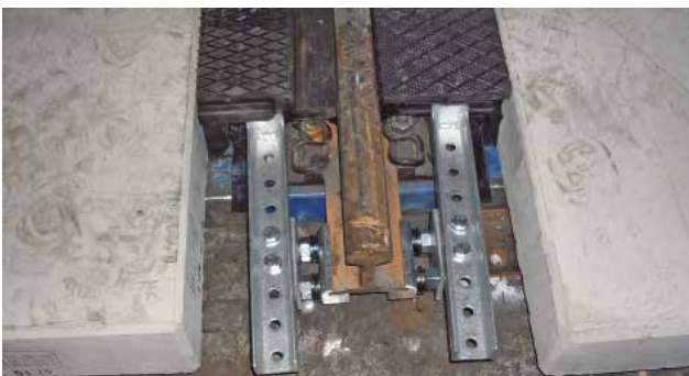
Die Verschiebesicherung an den Profilen satt anliegen lassen und verschrauben. (Die Verschiebesicherung nicht zu fest anbringen um Überpressen zu vermeiden).
