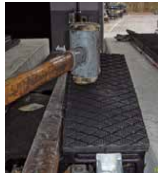
Einschlagen und Ausrichten der profilSTRAIL Elemente mit dem Kunststoffhammer.
