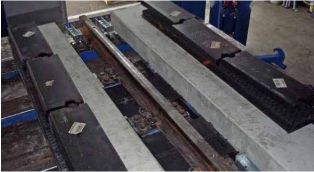
Bereitstellen der Schienenformstücke und der profilSTRAIL Außen- und Innenelemente.
